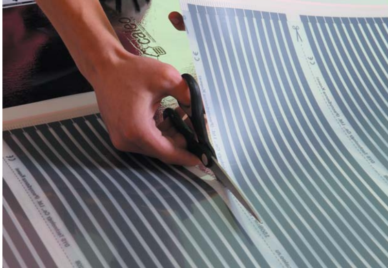
Рис. 5. Разрезание термопленки CALEO по линиям отреза
