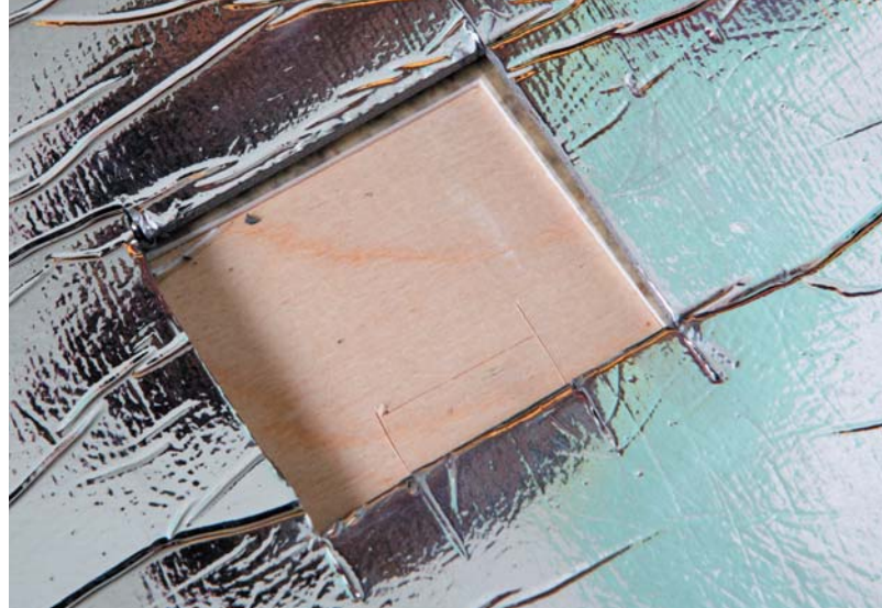
Рис. 22. Отверстие под датчик температуры пола в теплоотражающем материале
