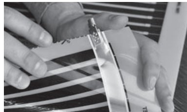
Рис. 5. Установленный на термопленку контактный зажим
