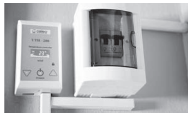
Рис. 20. Терморегулятор, подключенный к сети через отдельный автомат
