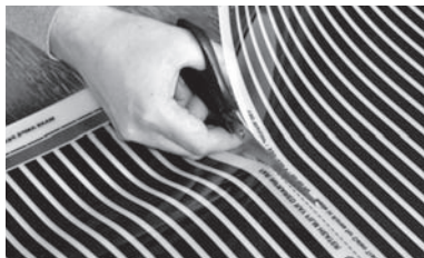
Рис. 4. Разрезание термопленки CALEO по линиям отреза
