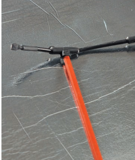
Рис. 5. Изоляция конца полосы UNIMAT
