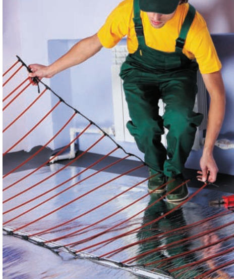
Рис. 9. Укладка разрезанной с одной стороны полосы UNIMAT на теплоотражающий материал с последующим разворотом мата
