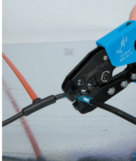
Рис. 12. Обжатие клещами соединительной гильзы
